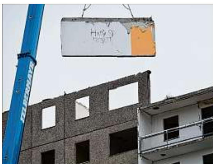
Sag' beim Abschied leise Servus: Ein Kran hebt eine Betonplatte von einem Neubau ab.
