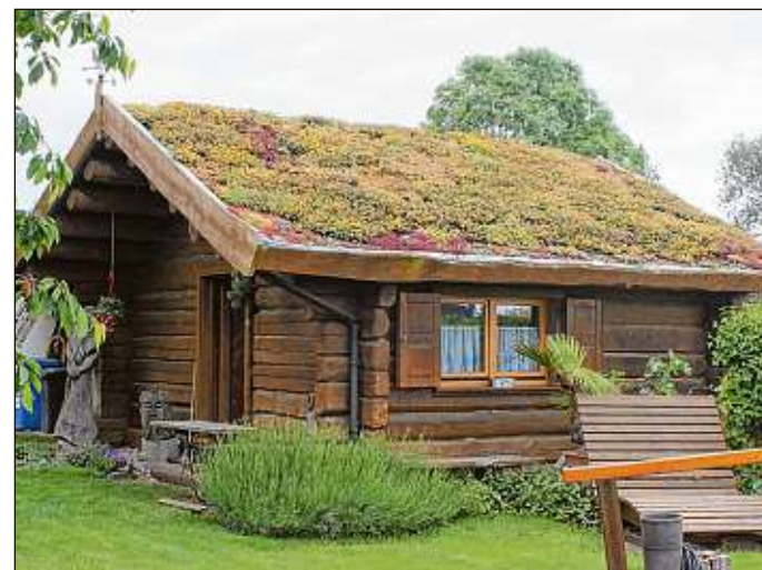
In Gänze: Das Holzhaus im Garten mit seinen dicken Balken, die ineinandergreifen und dem Bau so Festigkeit geben.
