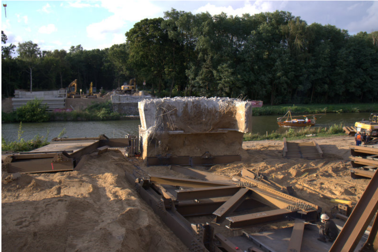
Die Widerlager der alten Steinfurter Brücke
