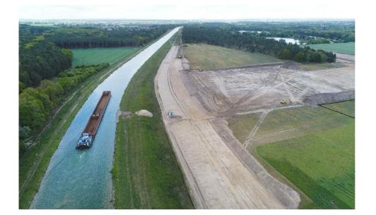
Frische-Kur für einen alten Herrn: Seit Anfang April laufen in Finowfurt die Arbeiten zur Verbreiterung und Vertiefung des Oder-Havel-Kanals. Der neue Damm wird auf der Südseite des Kanals errichtet. Bis 2026 sollen die Arbeiten abgeschlossen sein. © Foto: MOZ/Thomas Burckhardt
